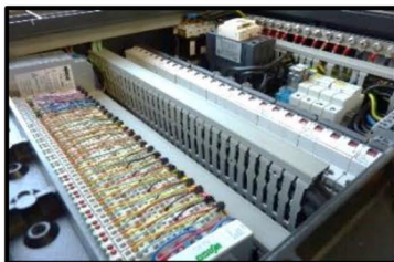
Ilot Ethernet intégré dans la baie
